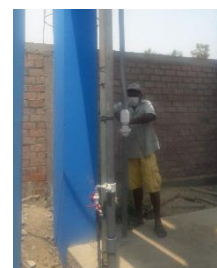
Ejecución de sistema de apoyo de Agua en Casa
