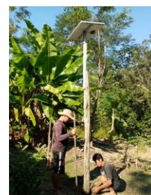
Instalación de nuevo sistema fotovoltaico domiciliario de tercera generación
